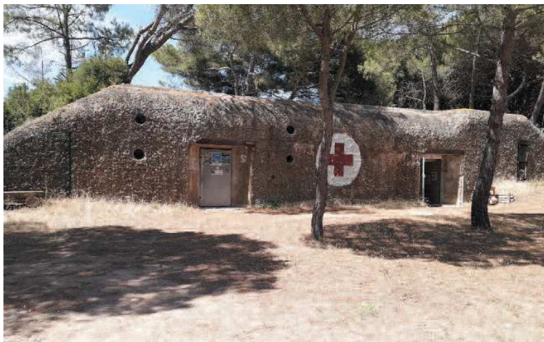
Blockhaus à La Tamarissière.
